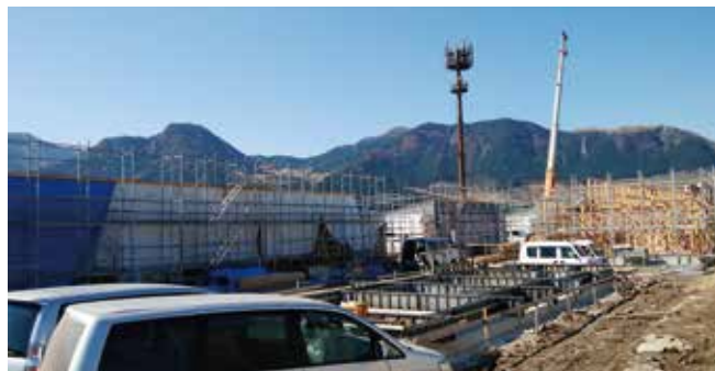
建設中の下西原第1団地(加勢)
